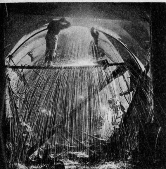
На строительстве киевского метро
